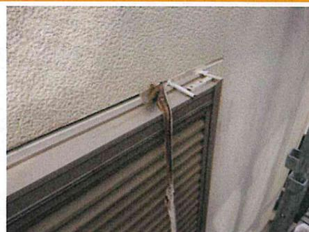
シーリング打ち替え工事物件（サッシ上部左右約10cmにアルミパイプが設置）アルミパイプが水分を逃がす役割
