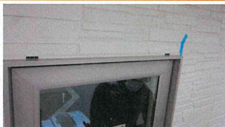
サイディングボードメーカー部材（水抜き材）サッシ上部左右2ヶ所約5cm～10cmの位置に設置（サッシのサイズで水抜き材の設置個数が異なります）シーリングが埋まっていない部分が水分を逃がす役割
